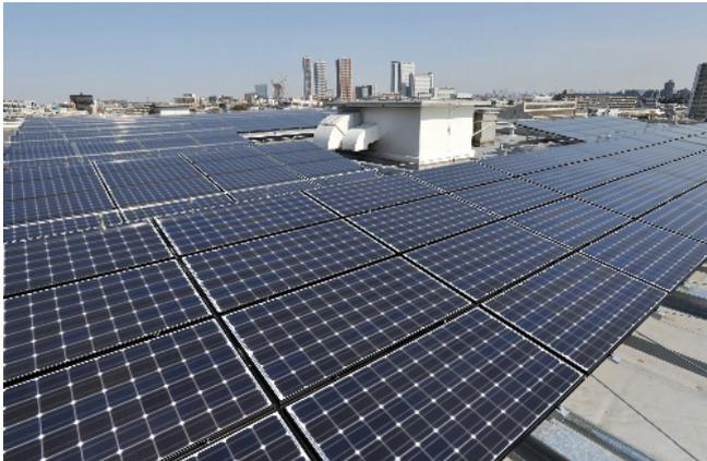
2012年3月30日、川崎工場屋上に設置した472枚の太陽電池パネルで発電を開始してから7年が経過しました。最大出力100kW、年間発電量予測は11万kWhを見込んでいましたが、実際の発電量実績は12年度が129,270kWhで18年度の発電量は122,194kWhと検討段階での予測を10%以上超える高効率発電を実現できています。
